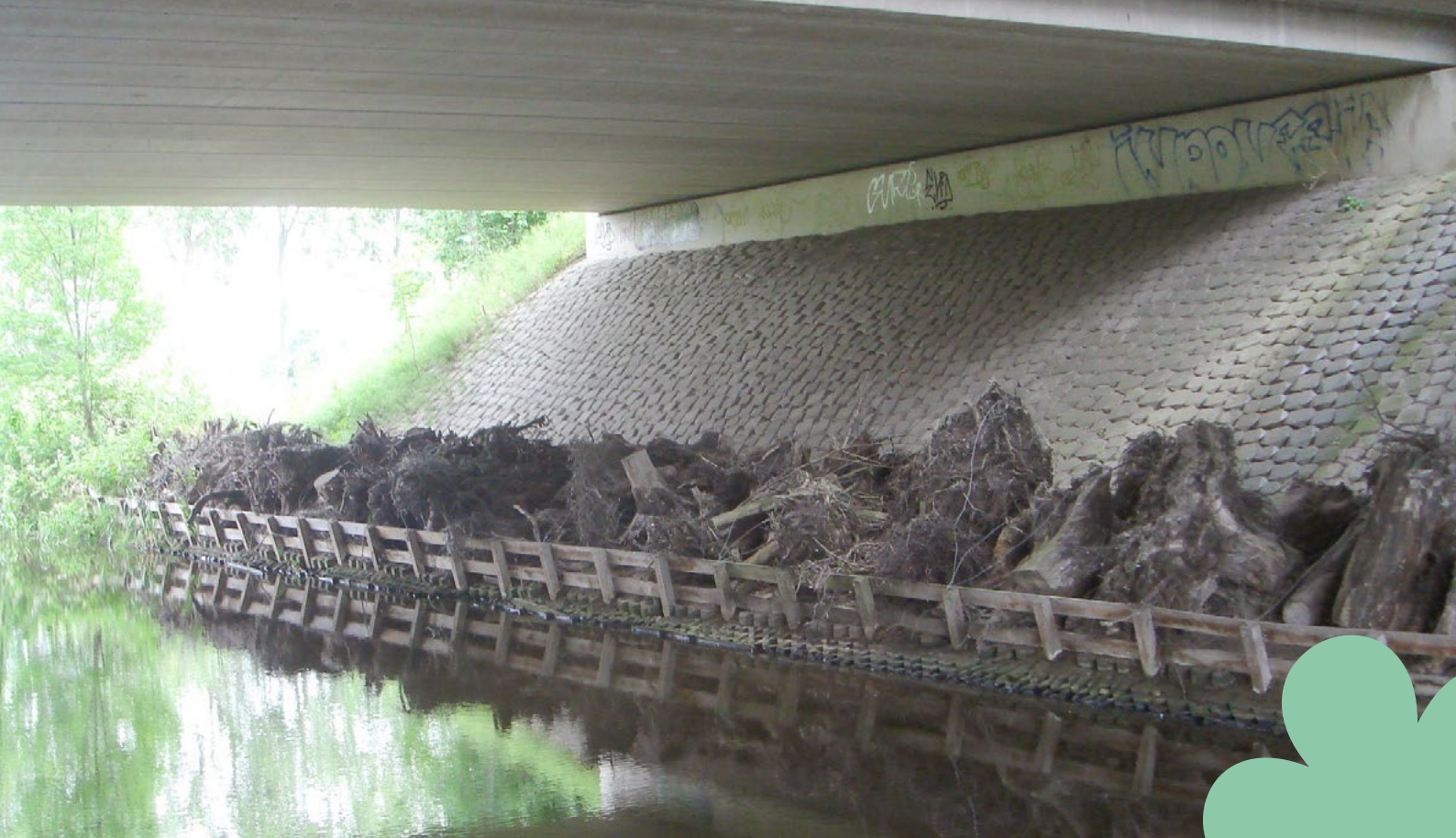
Figuur 4.7 – Stobbewal onder een viaduct. De boomstobben bieden een schuilplaats aan allerlei dieren, zoals kleine zoogdieren, amfibieën en reptielen en zijn daardoor voor deze dieren aantrekkelijk om langs te trekken (foto Waardenburg Ecology).
