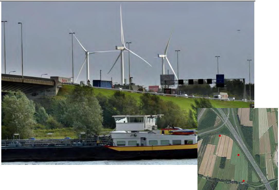
Figuur 4 Voorbeeld van een lijnopstelling met een lichte knik die vanuit bepaalde hoeken niet als zondanig waarneembaar is (windpark Autena Vianen, gemeente Vijfheerenlanden)
